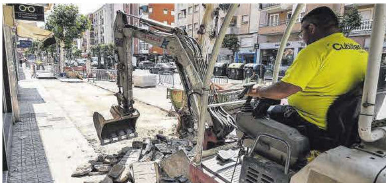
Un operario levanta las baldosas en mal estado para sustituirlas por otras nuevas en Ricardo Carapeto.
