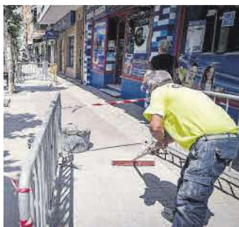
Un obrero remata el nuevo acerado instalado.
